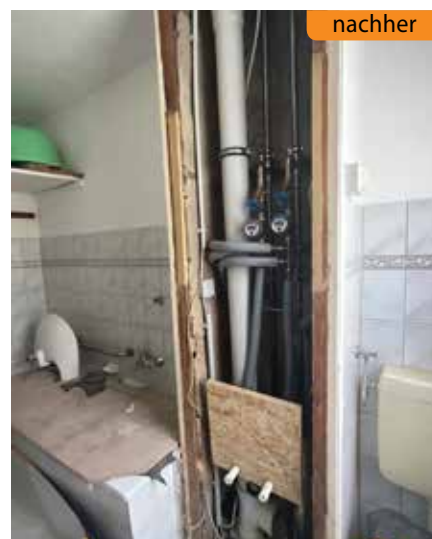
Strangsanierung Typ Magdeburg
