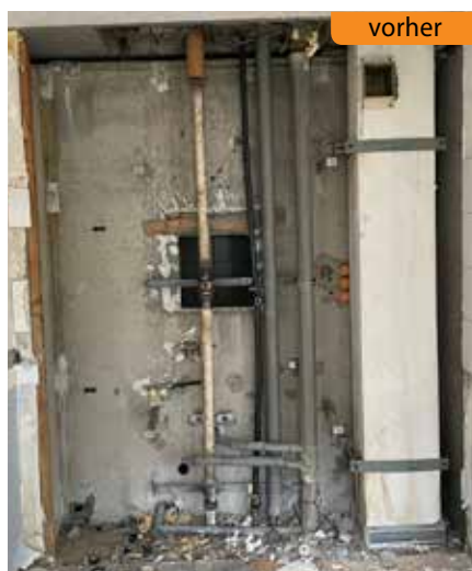
Strangsanierung Typ WBS70
