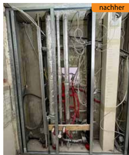
Strangsanierung Typ WBS70
