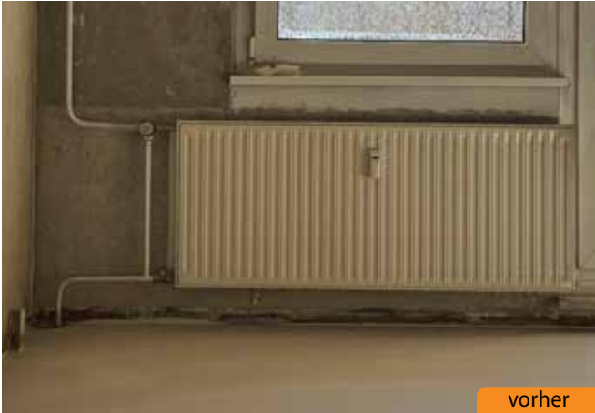
Einrohrheizung vor dem Umbau
