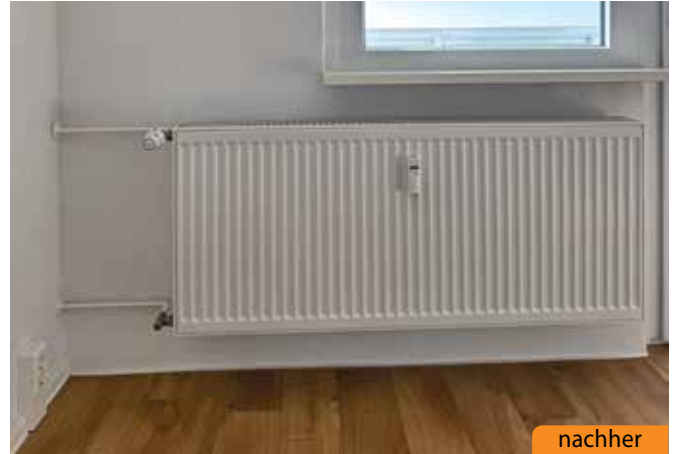
Umgebaut in Zweirohrheizung
