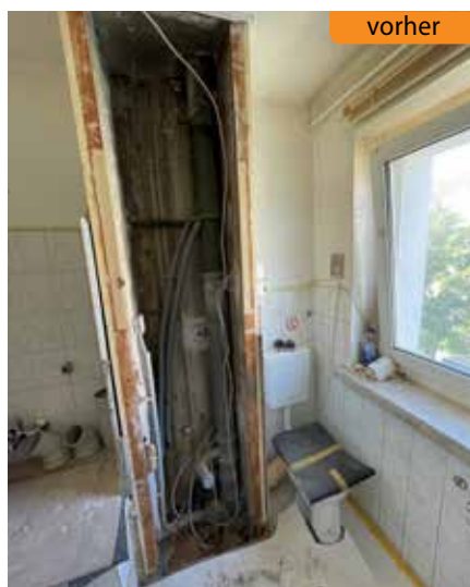
Strangsanierung Typ Magdeburg
